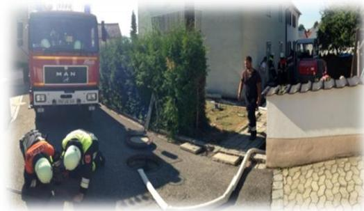
Bei Baggararbeiten wurde ein Hauswasseranschluss abgerissen. Der Keller konnte vor einem Eindringen des Wassers durch den Einsatz von einer Tauchpumpe geschützt werden. Die Wasserleitung wurde abgeschiebert. Weitere Maßnahmen wurden durch den örtlichen Wasserversorger getroffen.
